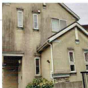
施工前（屋根 | 築12年）
