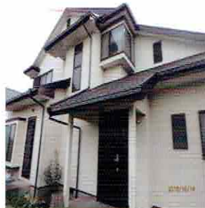
施工前（外壁 | 築15年）
